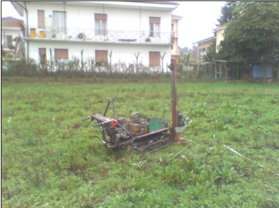
Foto n.1: Prova penetrometrica dinamica
